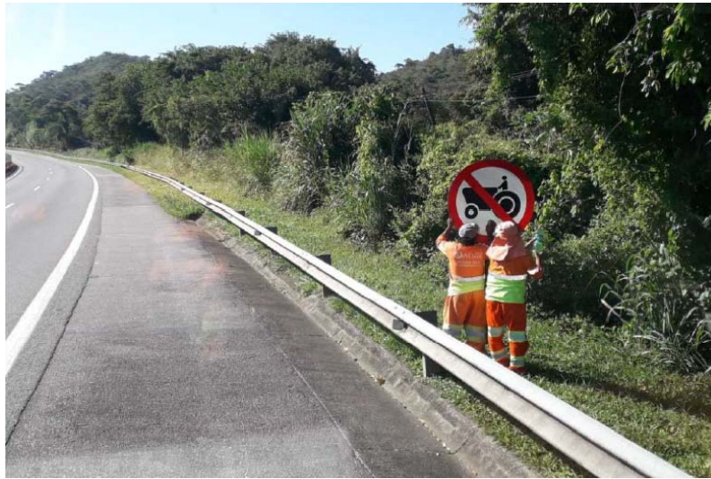
Foto 4 – Limpeza de placa – Km 05+800 Sul
