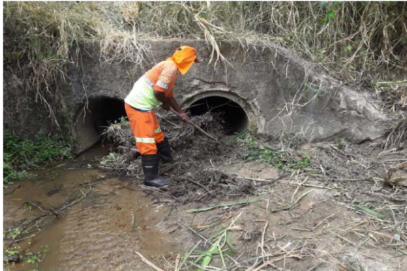
Foto 8 – Limpeza de bueiro – Km 17+800 Norte
