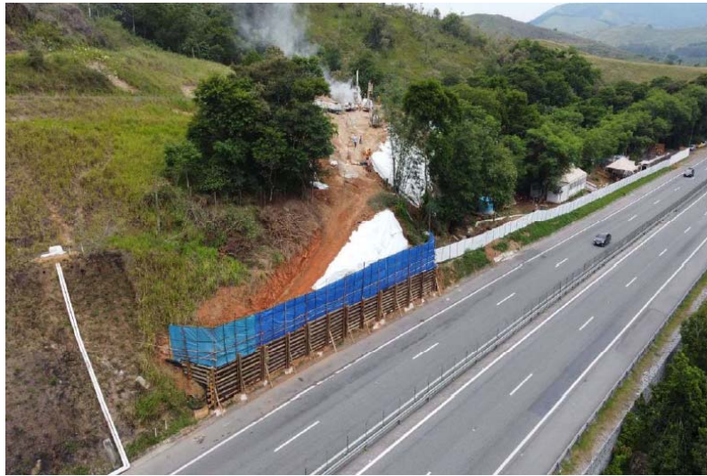
Foto 11 – Obra de recuperação de talude – Km 15+700 Sul
