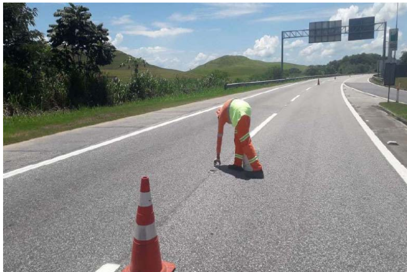
Foto 5 – Implantação de tachas – Km 23+000 Sul
