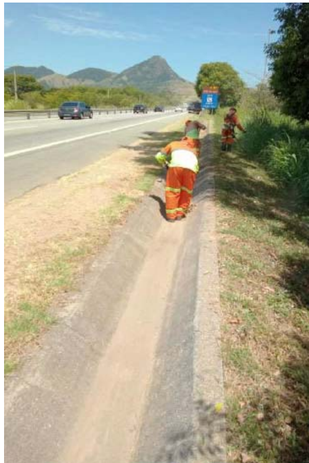
Foto 7 – Limpeza da canaleta e corte – Km 12+100 Sul
