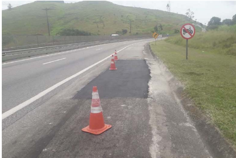
Foto 1 – Acostamento – Km 10+000 Sul
